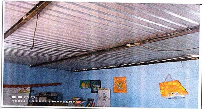
Foto 6 : Sustitución de Láminas
